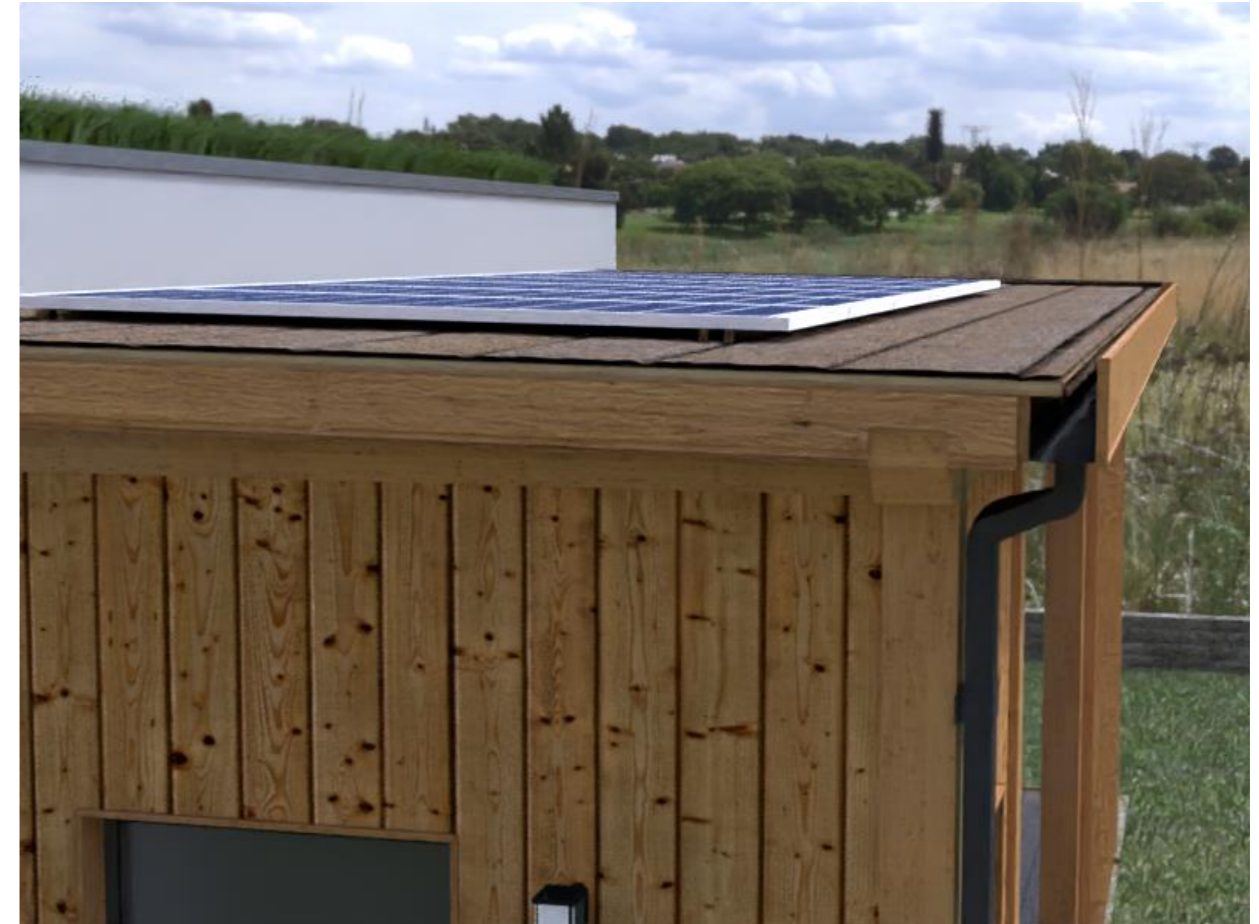
Detalle cubierta ligera con tela asfáltica
